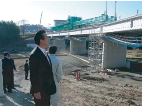
原市、磯部を結ぶ建設中の橋を視察（原市）
