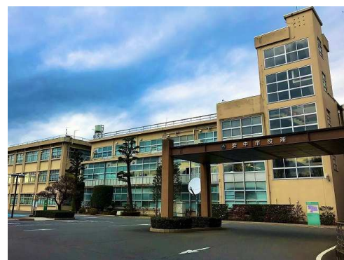
老朽化に加え、耐震性にも不安がある旧庁舎
